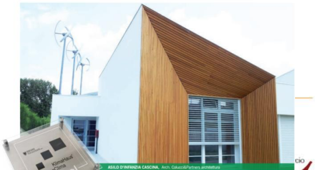
ASILE D'INFANZIA CASINA, Arch. Gaurici/Partners architettura
